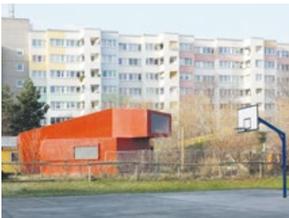
Parklife, multifunktionales Gebäude für die Freizeitbetreuung von Kindern, Wien 2010
