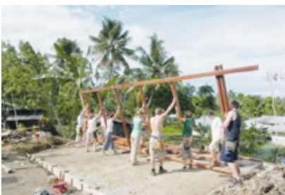
StudentInnen bei der Errichtung eines multifunktionales Gebäudes auf Nias Island, Indonesien, 2007
